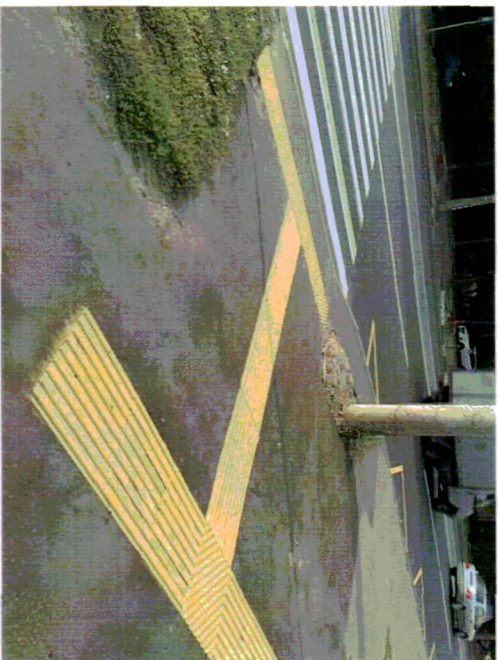
Рис. 12. Пешеходный переход, выполненный с применением материалов различной окраски и фактуры, имеющих различные звуковые и тактильные характеристики
