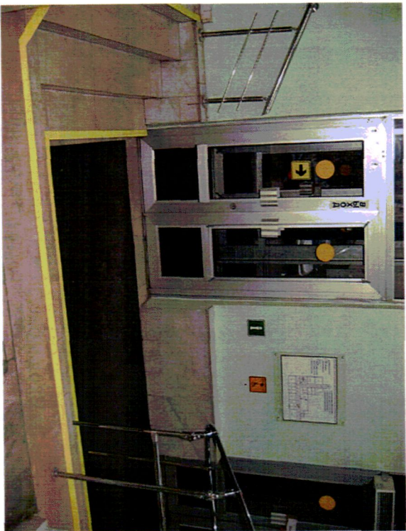
Рис. 3. Контрастная маркировка на прозрачных полотнох дверей
