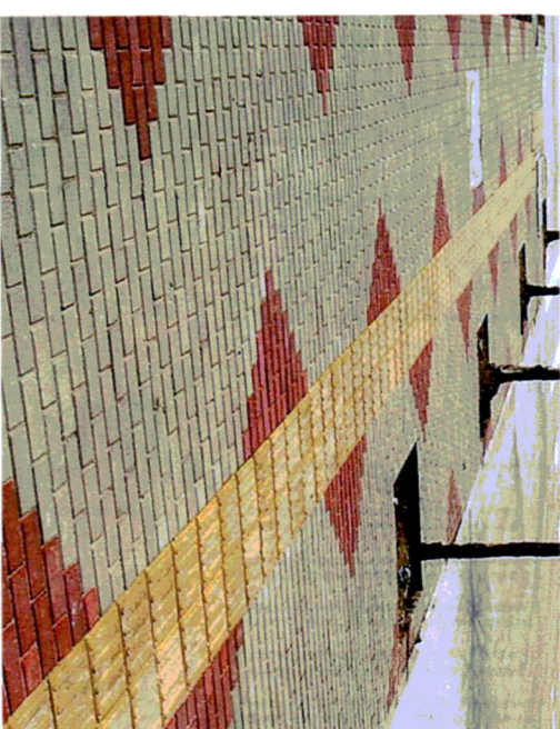
Рис. 13. Пешеходная дорожка, выполненная с применением материалов различной окраски и фактуры, имеющих различные звуковые и тактильные характеристики
