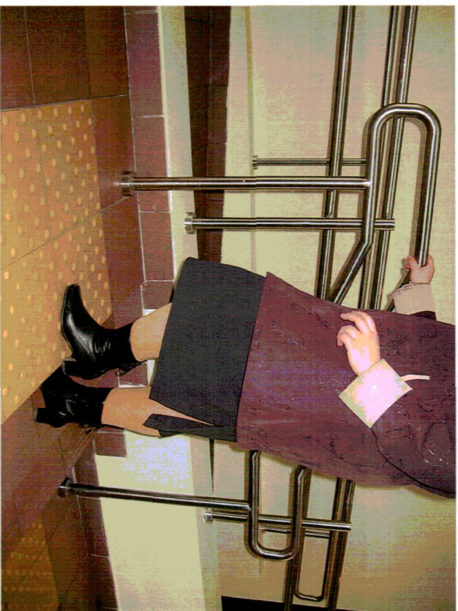
Рис. 8. Дестигичные поручни круглого сечения
